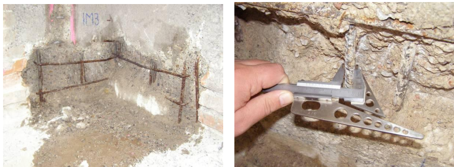
Slika 12. Kontrola količine i tipa ugrađene armature
