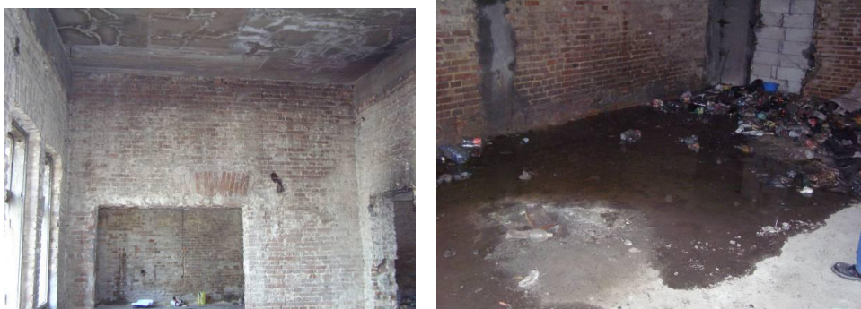
Slika 6. Izgled unutrašnjosti objekta
