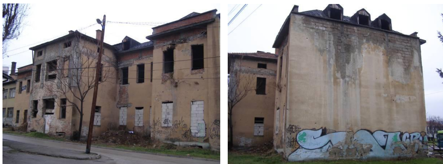
Slika 5. Izgled objekta sa zadnje i bočne strane (južna i istočna fasada)
